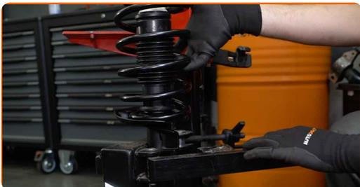
**51** Trate el asiento de montaje del puntal amortiguador en la mangueta de dirección. Use un cepillo de alambre. Use el aerosol WD-40.
