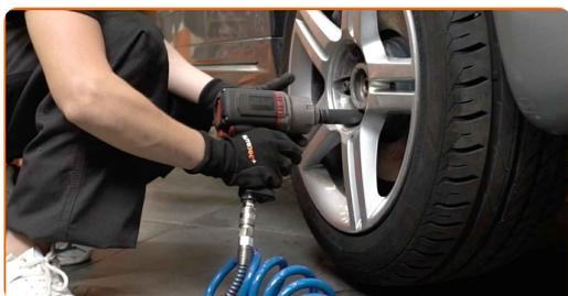
**29** Baje el automóvil y, manteniendo el orden cruzado, apriete los pernos de fijación de las ruedas. Utilice una llave de impacto para llanta # 17. Utilice una llave dinamométrica. Apriételo a un par de 120 Nm.
