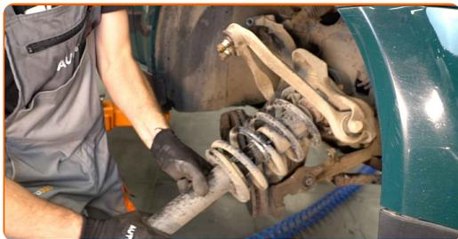
**26** Limpie las sujeciones del soporte superior del puntal amortiguador. Use un cepillo de alambre. Use el aerosol WD-40.
