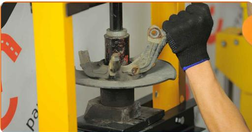
**34** Limpie el asiento de montaje del cojinete del cubo (buje). Use un cepillo de alambre. Use el aerosol WD-40.
